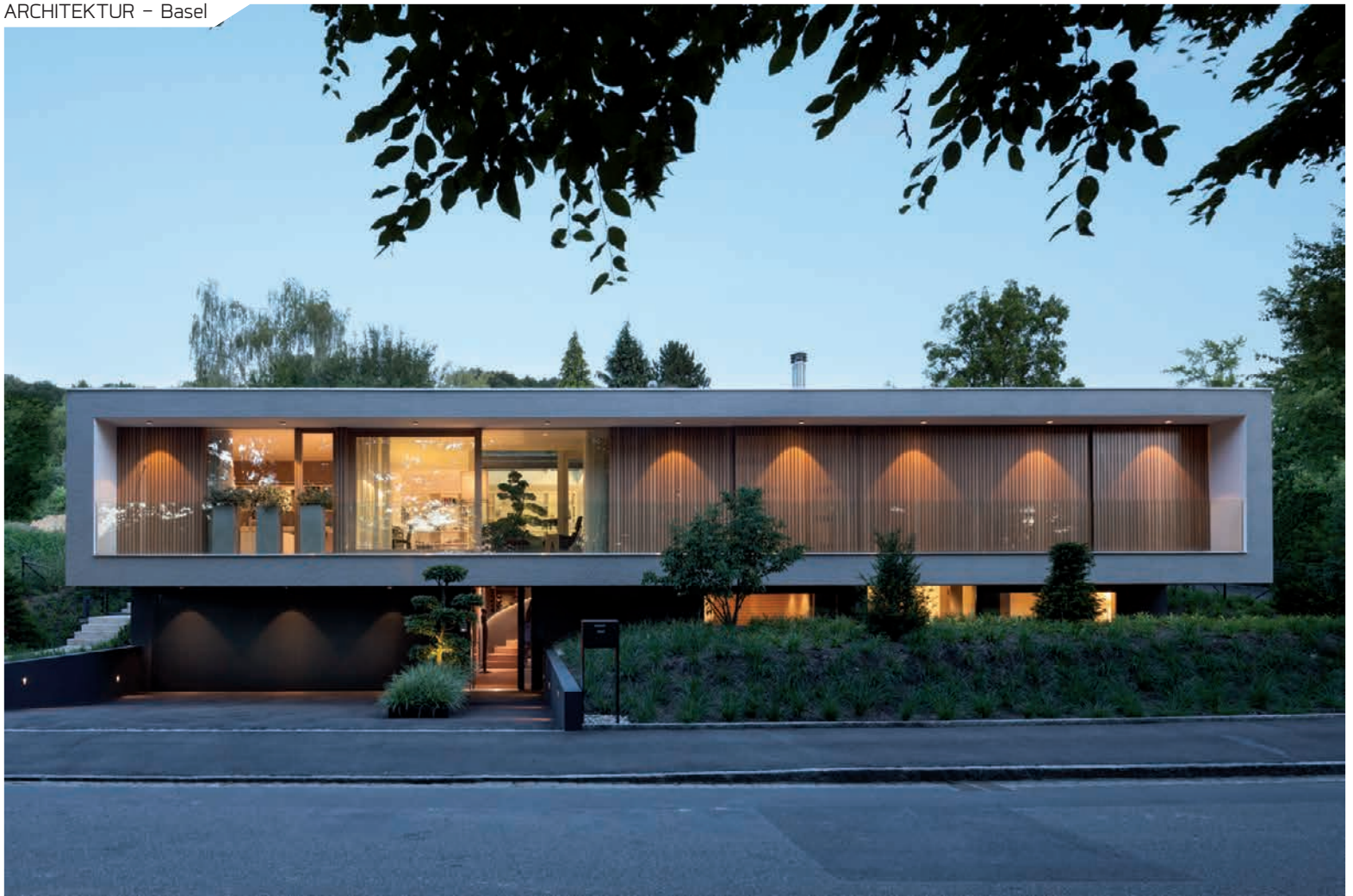
Strassenseitig zeigt sich das Haus mit einem zurückversetzten Sockelgeschoss, so dass die Wohnebene fast zu schweben scheint.
