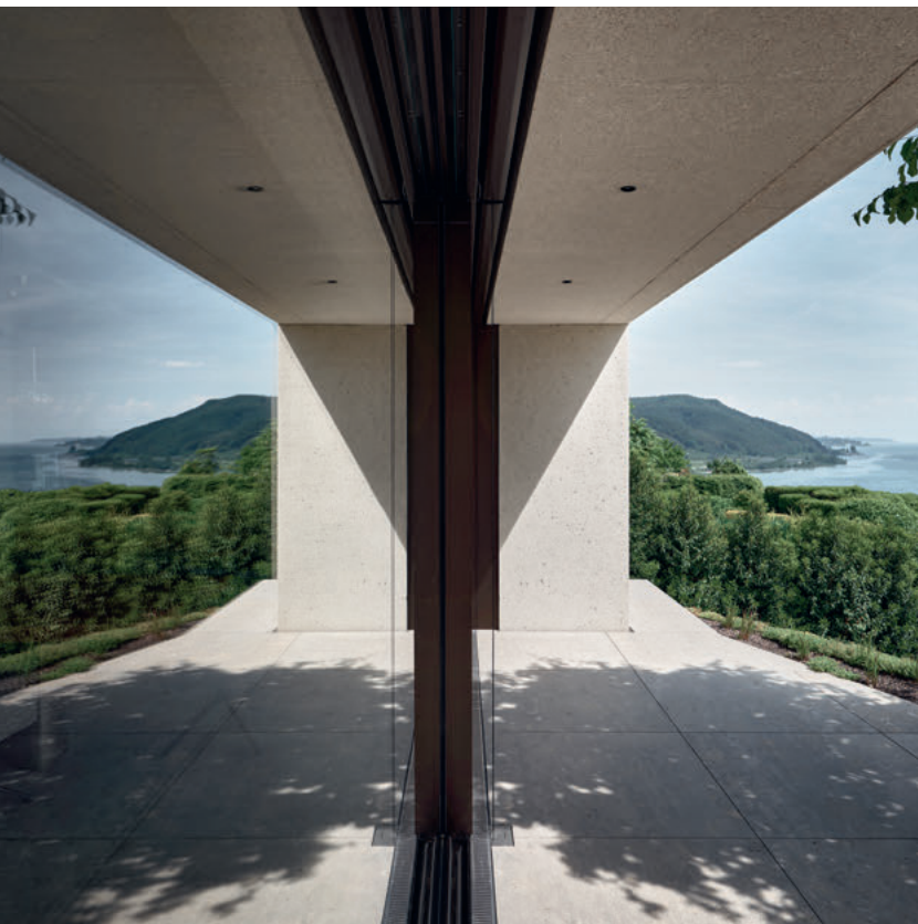
Maximale Transparenz, geschaffen durch die rahmenlosen Fenster von Sky-Frame, verbindet die Landschaft der Bodenseeregion nahtlos mit dem Inneren des Hauses.
